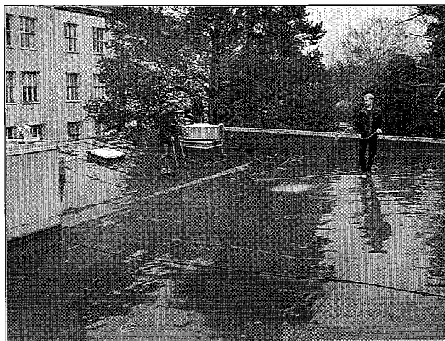
Läcksökning med hjälp av potentialdifferensmetoden
